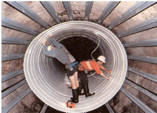
نوارهای UPVC نصب شده در لوله نصب نوارهای UPVC در کانالهای بزرگ با پشت بند
