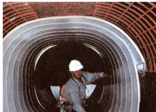
نصب نوارهای UPVC در کانالهای بزرگ با آرماتوربندی و توربندی UPVC و سوراخ تزریق سیمان
