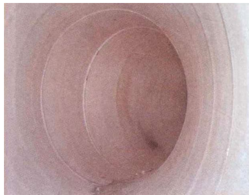
نوارهای UPVC نصب شده در لوله نصب نوارهای UPVC در کانالهای بزرگ با پشت بند
