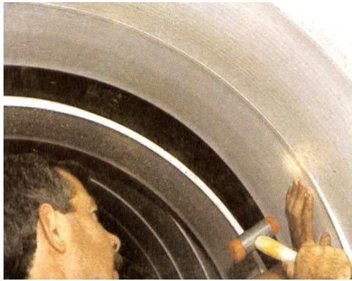
ارسال نوارهای UPVC به درون لوله و تنظیم آنها تنظیم نوارهای UPVC در لوله
