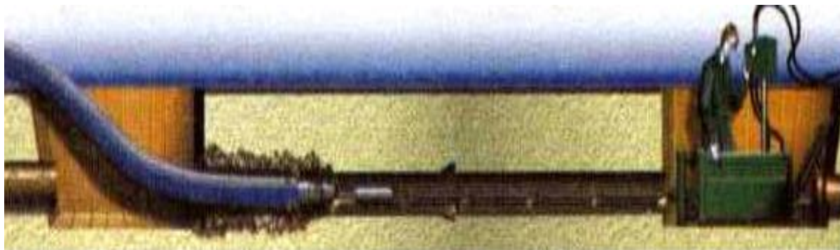
دام لوله قدیمی و جایگذاری آن با فشار و حرکت لرزشی
